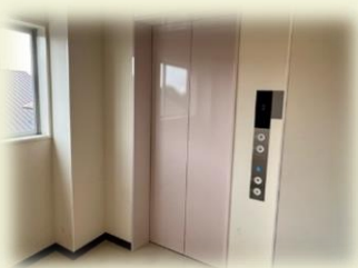
エレベーターの設置
