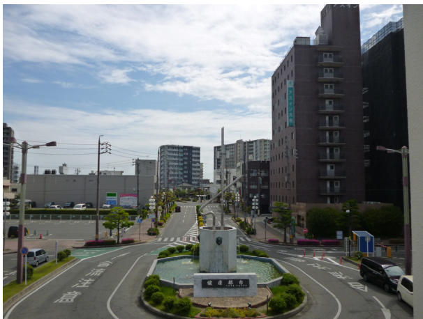
駅前広場や駅前道路の修景整備（大府駅前広場）
