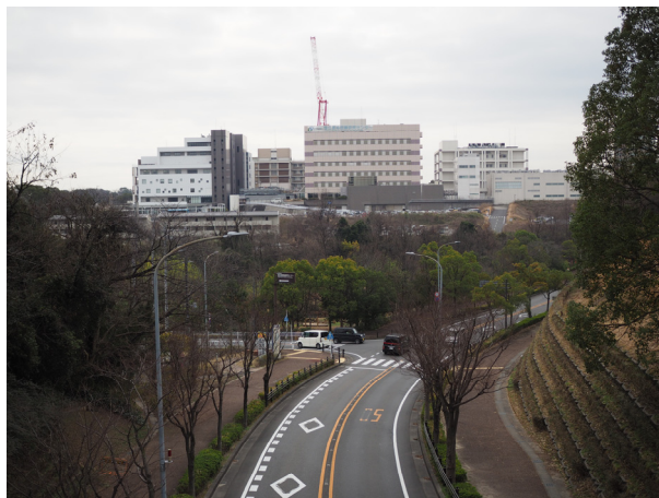
無電柱化の推進による景観の向上（（市）健康の森線）
