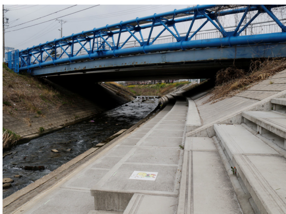
石ヶ瀬川（森岡橋付近）は親水性が高く、河川沿いの遊歩道も整備されている（月見町）
