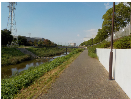
修景整備が進む鞍流瀬川緑道（江端町）
