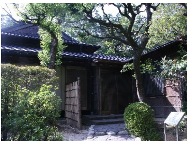
歴史資源の案内板設置（大倉公園休憩棟）
