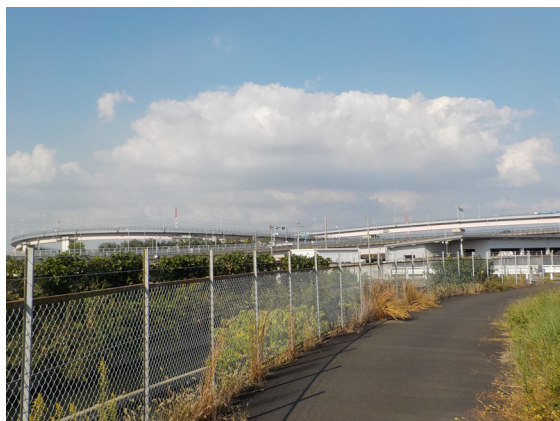
伊勢湾岸道路・名古屋南ジャンクション （共和町から名古屋市緑区方面）
