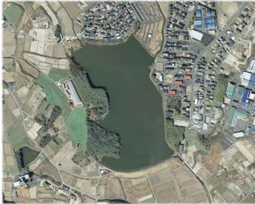
ため池に太陽光パネルを浮かべて発電する水上太陽光発電事業を行う予定 (豊明市 若王子池)
