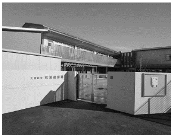
荒池保育園新園舎
